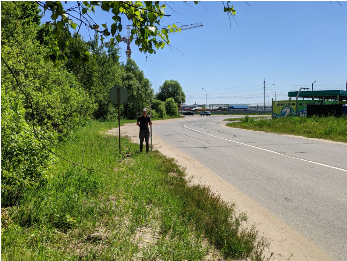
Рис. 11. Калужская область, г. Обнинск. «Реконструкция участка автодороги по улице Северная (от транспортной развязки «Северный въезд» до железной дороги) в городе Обнинске». Точка фотофиксации-5. Вид с северо-запада.
