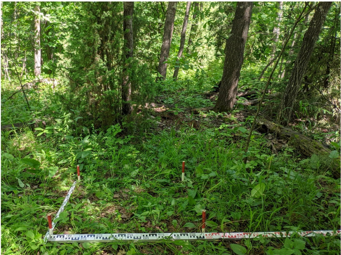
Рис. 20. Калужская область, г. Обнинск. «Реконструкция участка автодороги по улице Северная (от транспортной развязки «Северный въезд» до железной дороги) в городе Обнинске». Разметка поверхности шурфа-1 перед началом работ. Вид с юга.
