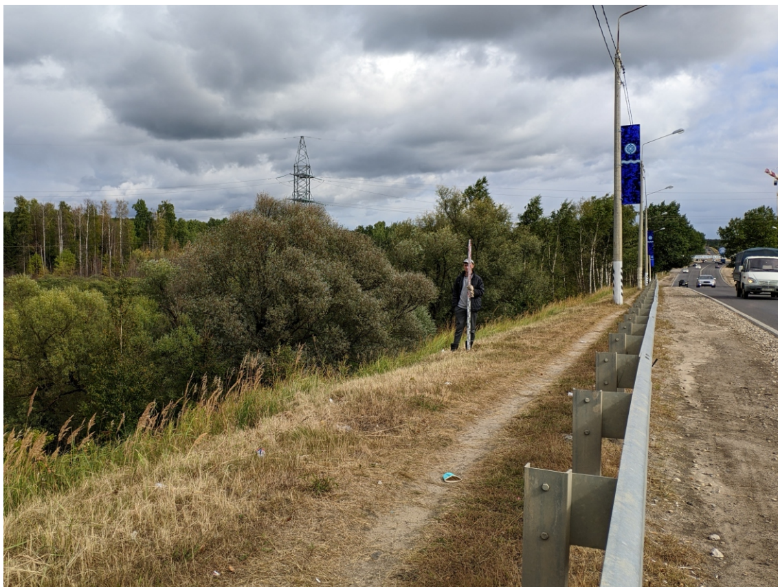
Рис. 7. Калужская область, г. Обнинск. «Реконструкция участка автодороги по улице Северная (от транспортной развязки «Северный въезд» до железной дороги) в городе Обнинске». Точка фотофиксации-1. Вид с запада.
