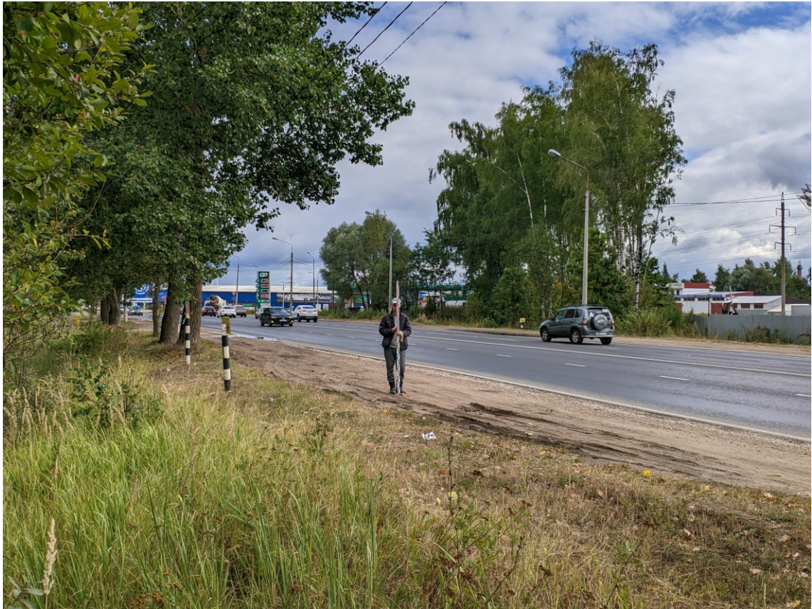
Рис. 13. Калужская область, г. Обнинск. «Реконструкция участка автодороги по улице Северная (от транспортной развязки «Северный въезд» до железной дороги) в городе Обнинске». Точка фотофиксации-7. Вид с северо-запада.
