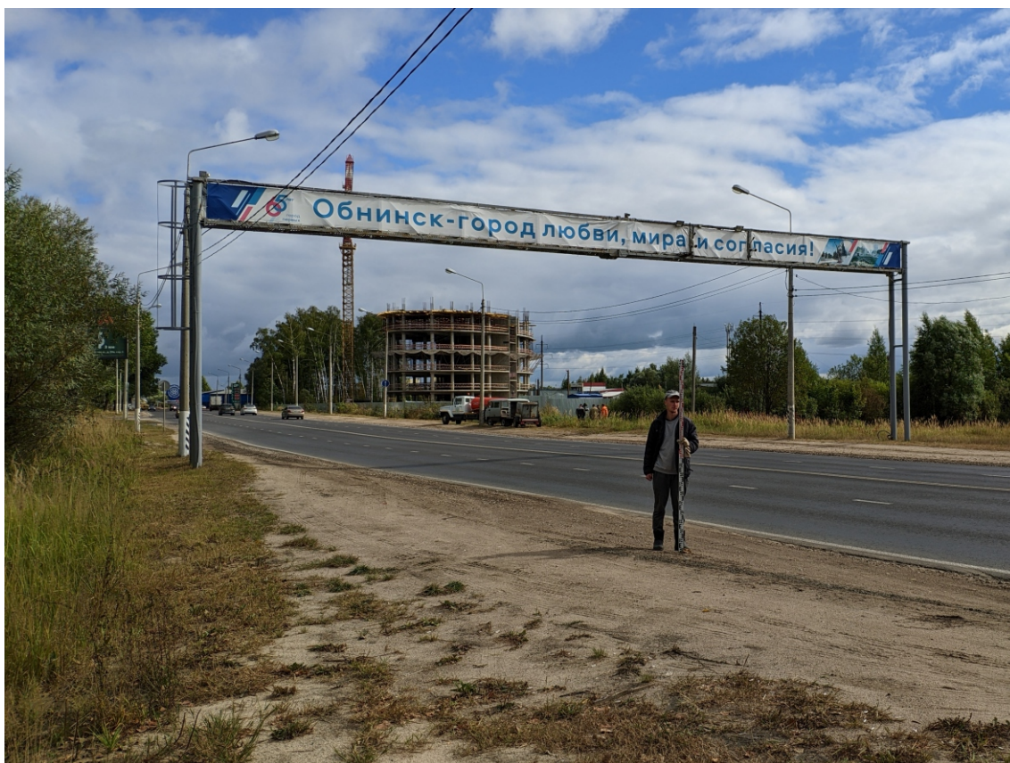
Рис. 8. Калужская область, г. Обнинск. «Реконструкция участка автодороги по улице Северная (от транспортной развязки «Северный въезд» до железной дороги) в городе Обнинске». Точка фотофиксации-2. Вид с северо-запада.
