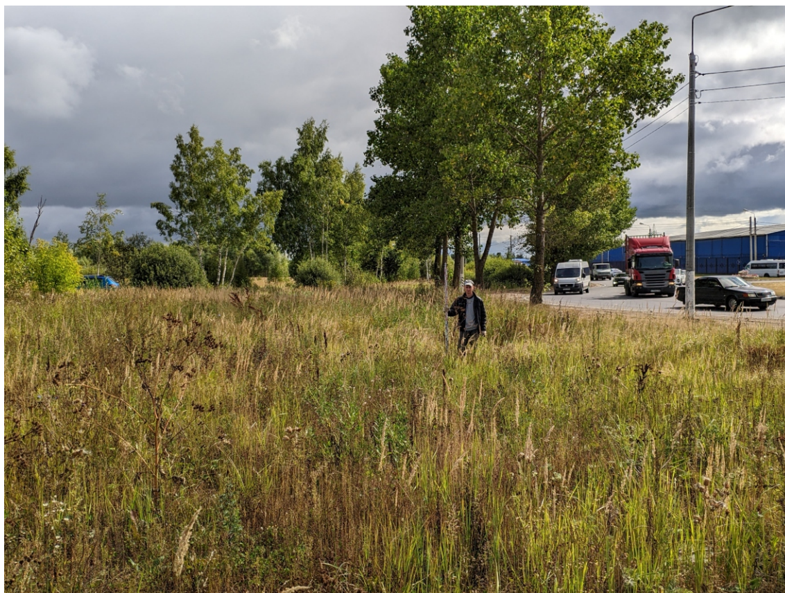
Рис. 16. Калужская область, г. Обнинск. «Реконструкция участка автодороги по улице Северная (от транспортной развязки «Северный въезд» до железной дороги) в городе Обнинске». Точка фотофиксации-10. Вид с северо-запада.
