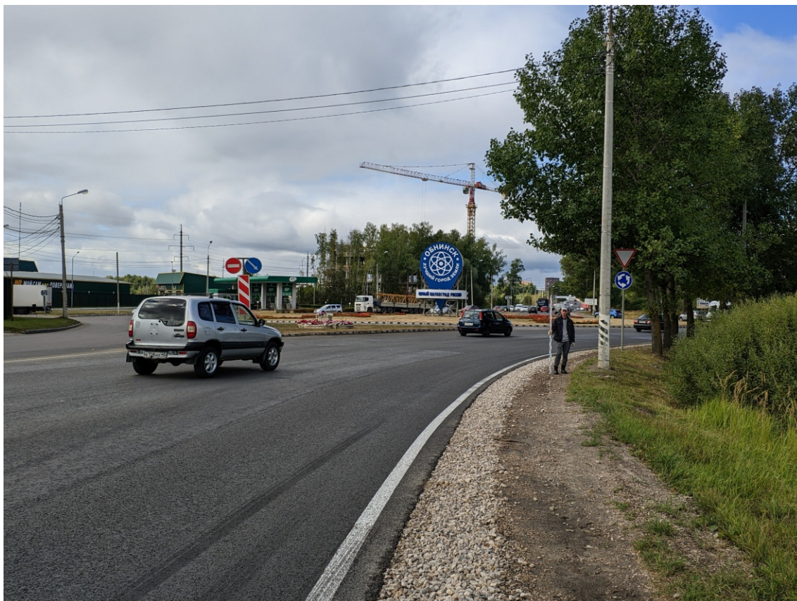
Рис. 17. Калужская область, г. Обнинск. «Реконструкция участка автодороги по улице Северная (от транспортной развязки «Северный въезд» до железной дороги) в городе Обнинске». Точка фотофиксации-11. Вид с востока.
