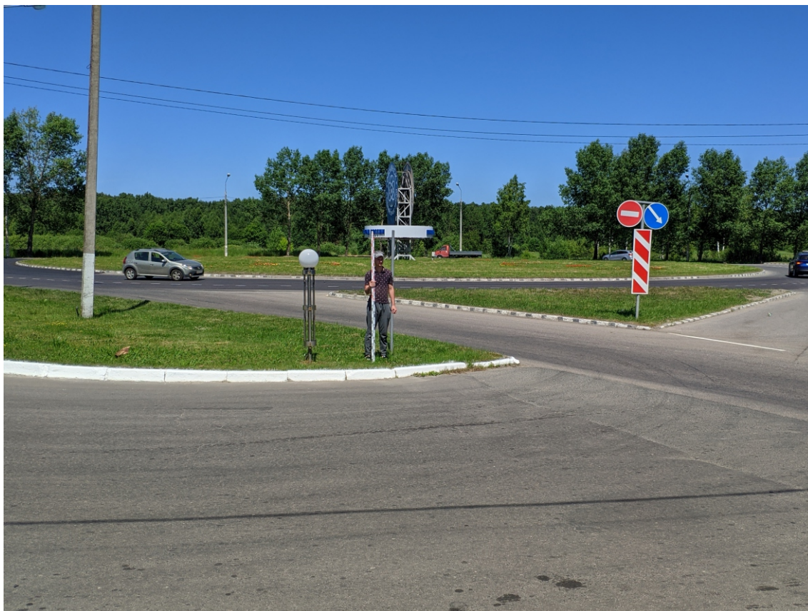
Рис. 18. Калужская область, г. Обнинск. «Реконструкция участка автодороги по улице Северная (от транспортной развязки «Северный въезд» до железной дороги) в городе Обнинске». Точка фотофиксации-12. Вид с юга.
