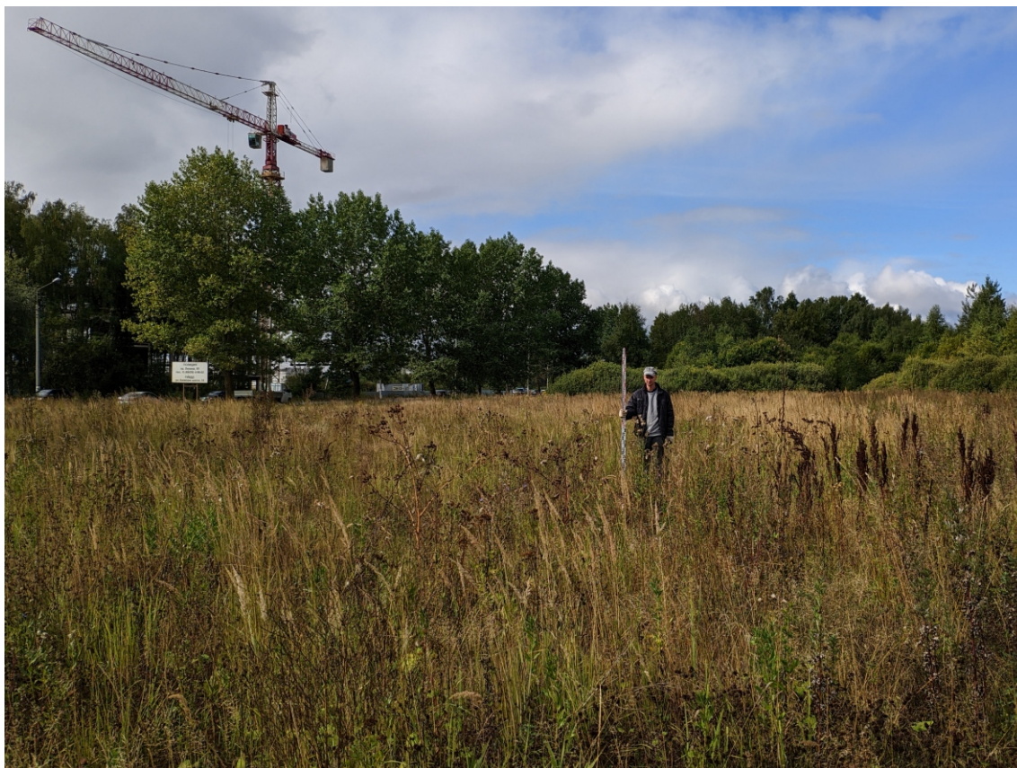
Рис. 15. Калужская область, г. Обнинск. «Реконструкция участка автодороги по улице Северная (от транспортной развязки «Северный въезд» до железной дороги) в городе Обнинске». Точка фотофиксации-9. Вид с востока.
