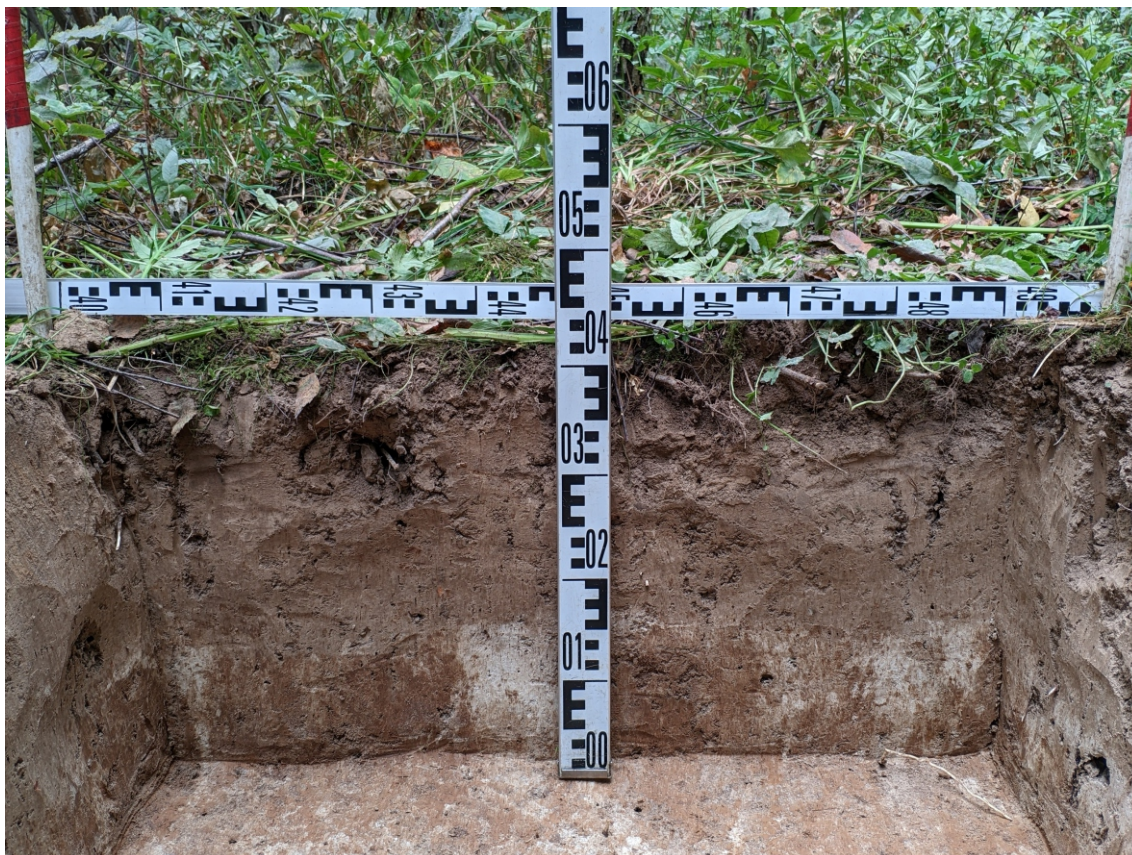
Рис. 45. Калужская область, г. Обнинск. «Реконструкция участка автодороги по улице Северная (от транспортной развязки «Северный въезд» до железной дороги) в городе Обнинске». Профиль северной стенки шурфа-7. Вид с юга.
